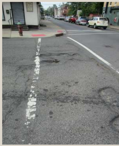
Figure 45. Uneven asphalt.
